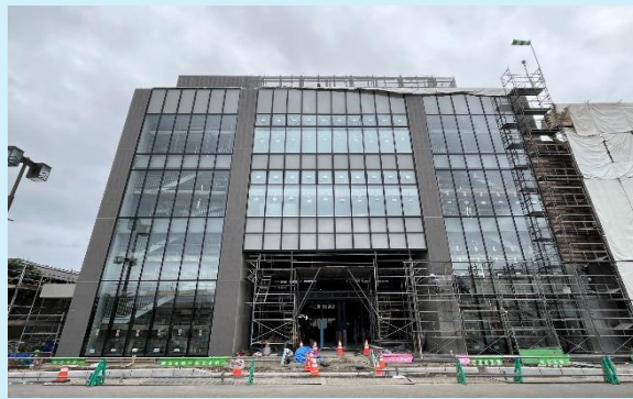
北面 外壁タイル張り施工状況
