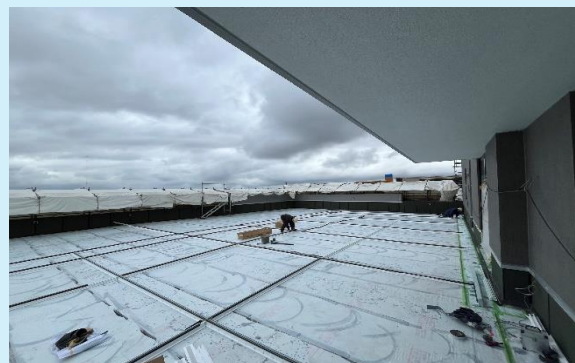
R階 シート防水施工状況
