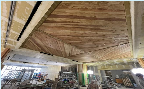
3階 天井杉板張り施工状況
