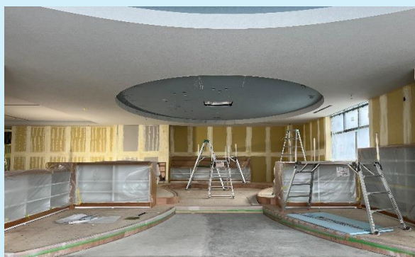
4階 おはなしの部屋施工状況
