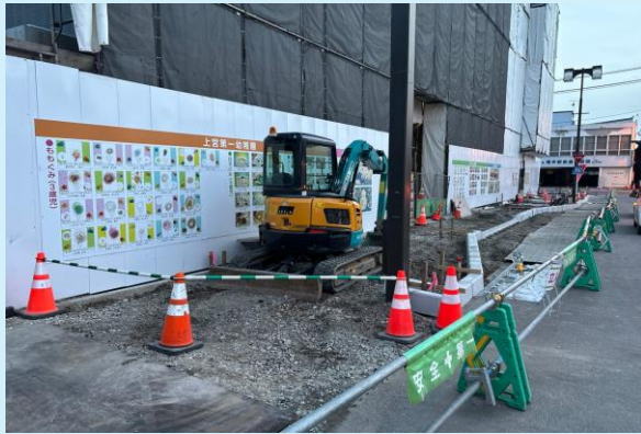
歩車道境界ブロック据付状況
