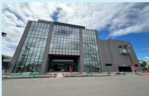
外観 完成状況
