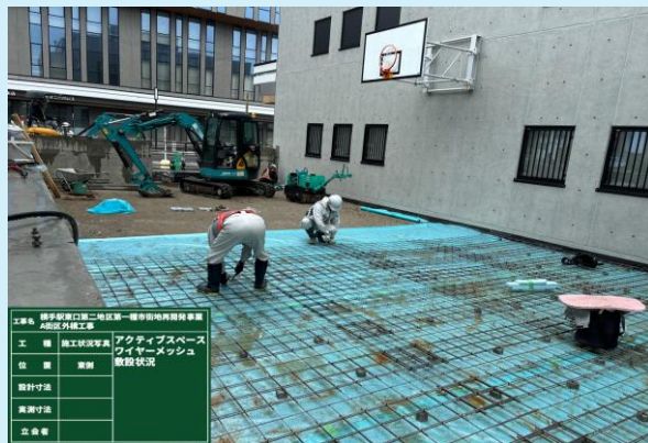
屋外アクティブスペース ワイヤメッシュ敷設状況
