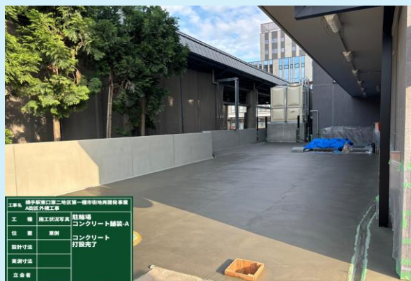
駐輪場 コンクリート打設完了状況
