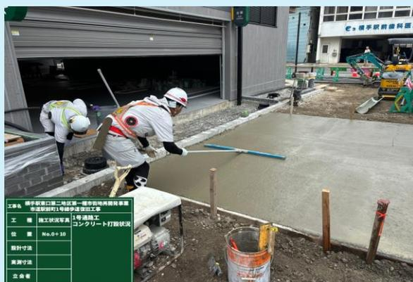
1号通路工 コンクリート打設状況
