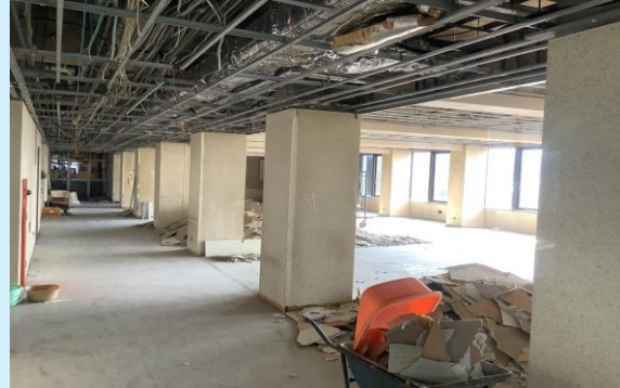
JA秋田ふるさと 内部解体状況
