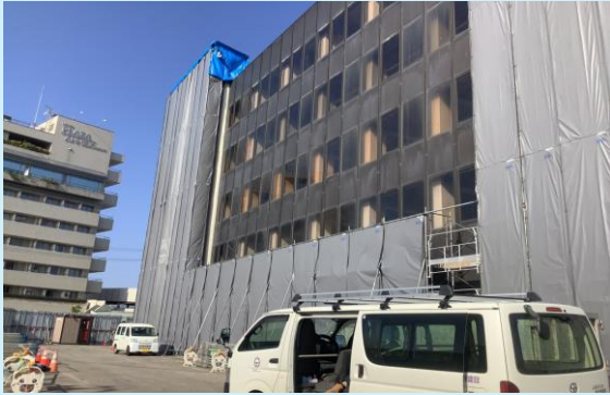
JA秋田ふるさと 足場組立状況
