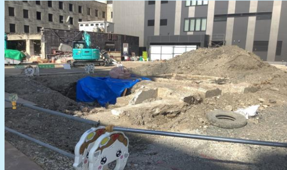
旧あたごビル駐車場 基礎解体状況
