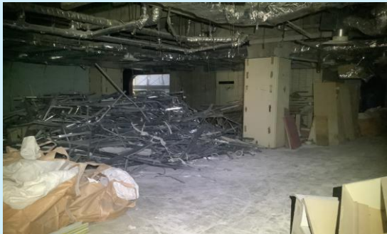
横手ステーションホテル 内部解体状況
