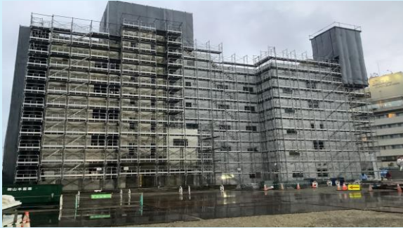
JA秋田ふるさと 北面足場組立状況
