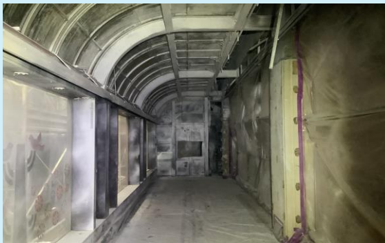
横手ステーションホテル 1階北側パネル解体状況
