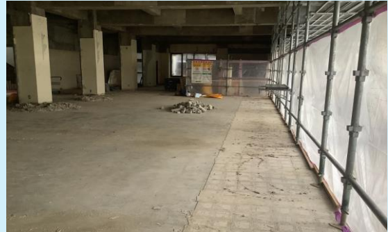
JA秋田ふるさと 4階内部解体状況
