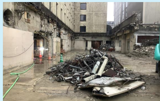
横手ステーションホテル 外部解体状況
