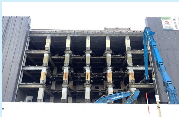
JA秋田ふるさと 南面躯体解体状況
