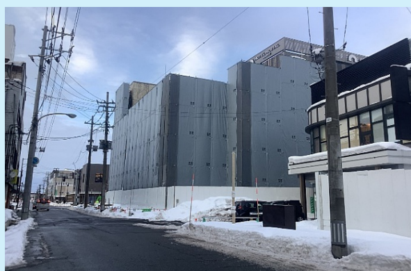
横手ステーションホテル 西面足場組立状況
