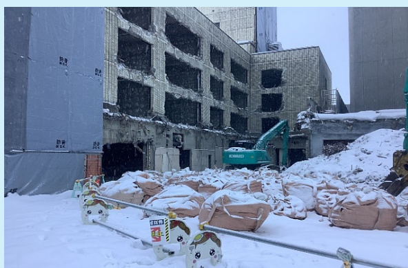
横手ステーションホテル 南面躯体解体状況
