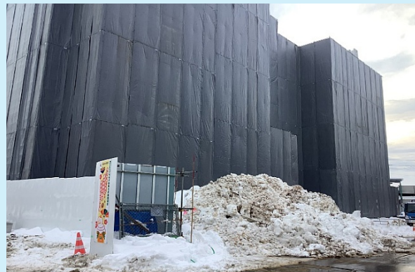
JA秋田ふるさと 北面足場組立状況
