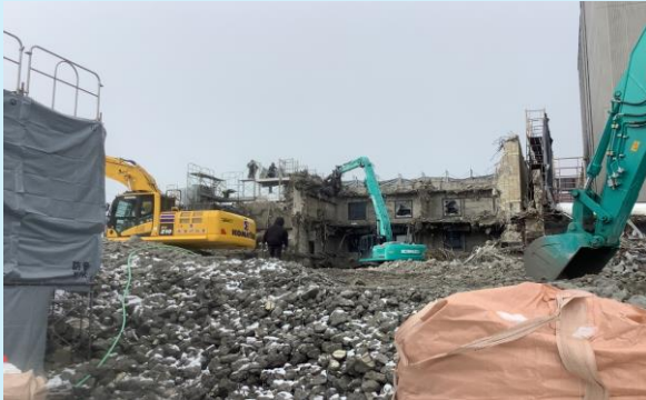
横手ステーションホテル 北面躯体解体状況
