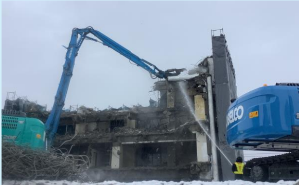
JA秋田ふるさと 北面躯体解体状況
