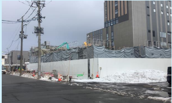
横手ステーションホテル 西面仮囲い状況
